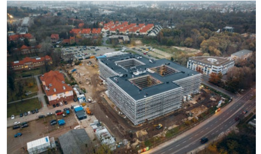
Baufeld Neubau Bundespolizeipräsidium in Potsdam
